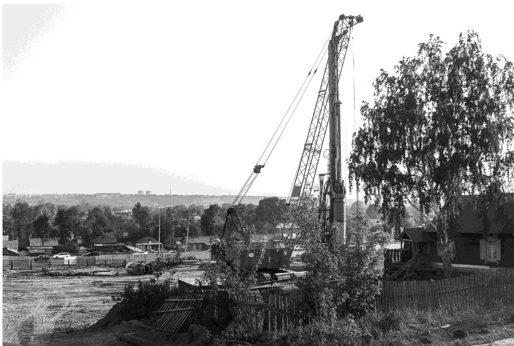
Рис. 17. Строительство Бугринского моста, дома, подлежащие сносу в районе между улицей Большевицкой и остановочной железнодорожной платформой Камышинской, 2012 Construction of Bugrinsky Bridge, houses to be demolished in the area between Bolshevistskaya Street and Kamyshinskaya stop railway platform, 2012
