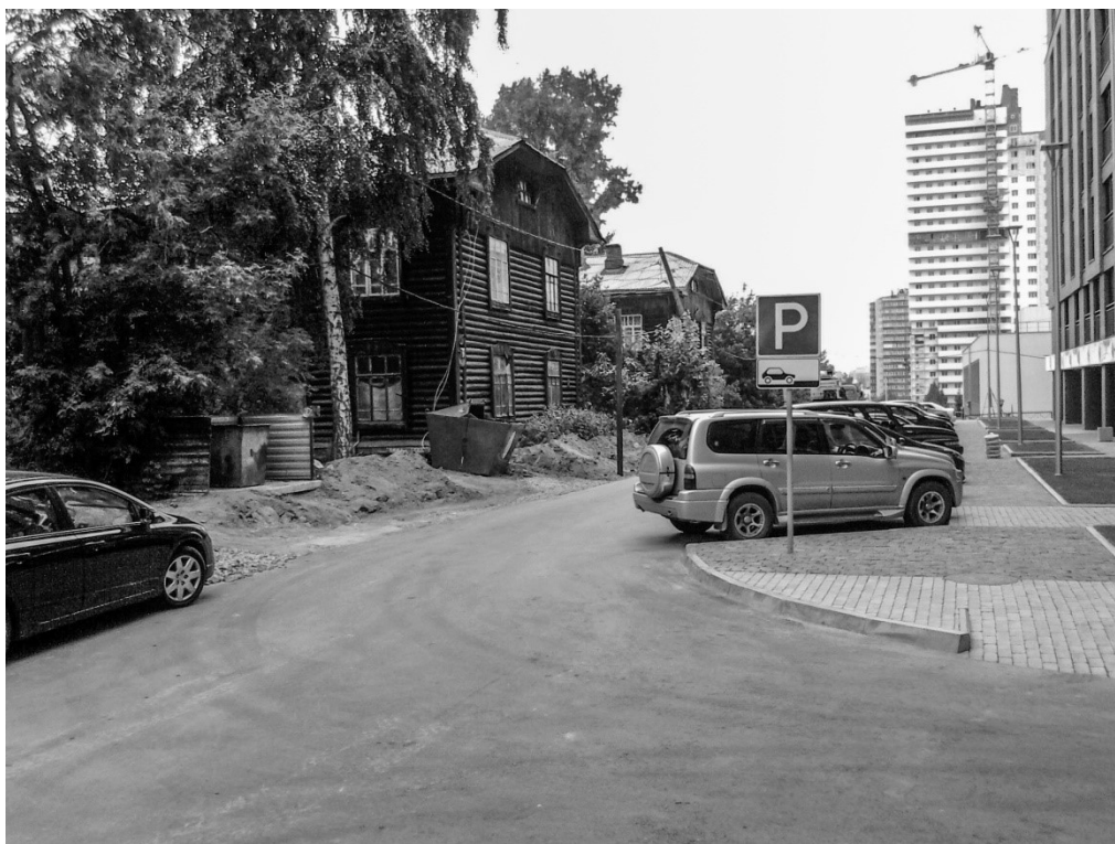
Рис. 5. Бараки на улице Декабристов (район метро «Октябрьская»), 2014 Barracks on Dekabristov Street (Oktyabrskaya metro area), 2014
