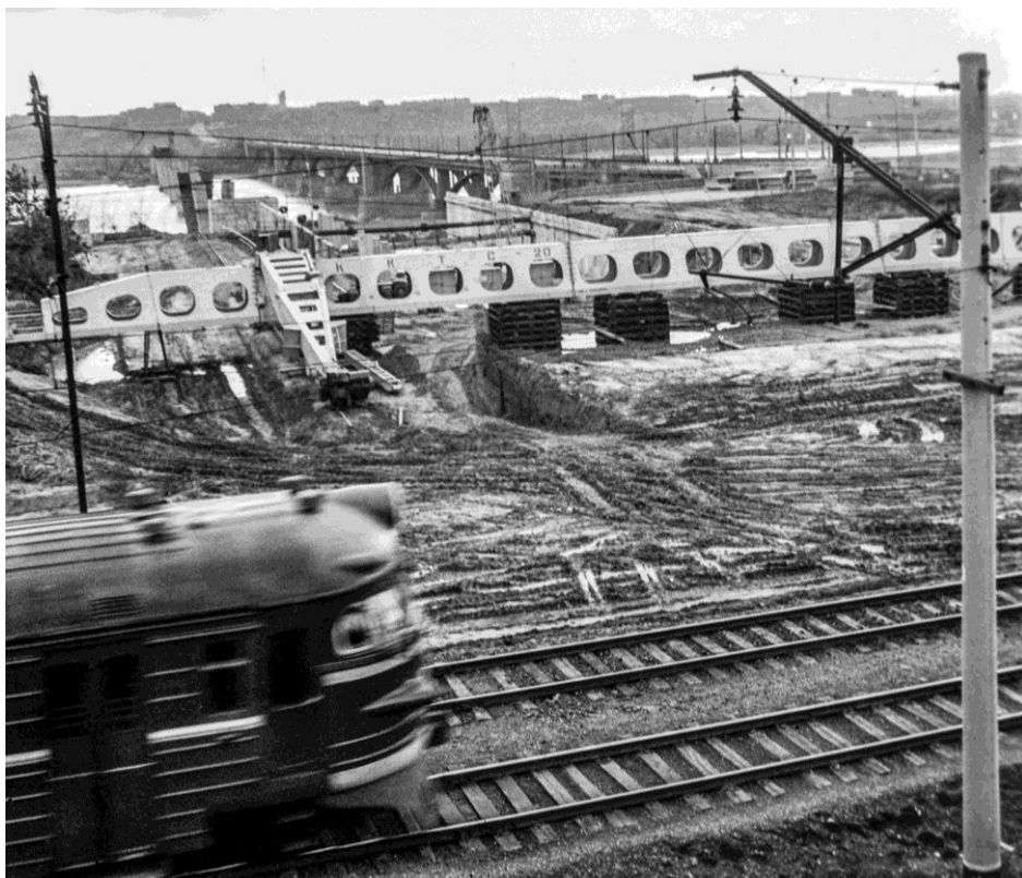
Рис. 12. Начало работ по строительству станции метро «Речной вокзал», 1983 Beginning of works on construction of Rechnoi Vokzal metro station, 1983
